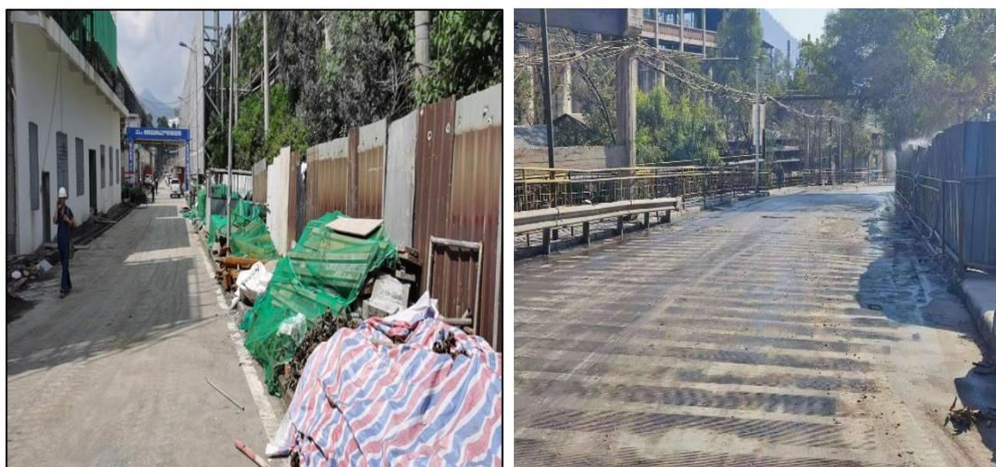
施工场地设置围挡和施工场地配备喷雾抑尘设备
