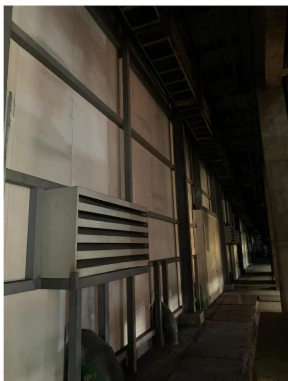
图 金属制品实施厂房封闭及增设隔音屏障
