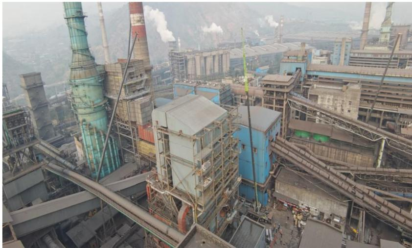
图：改造完成的新 2 号烧结烟气脱硝装置
