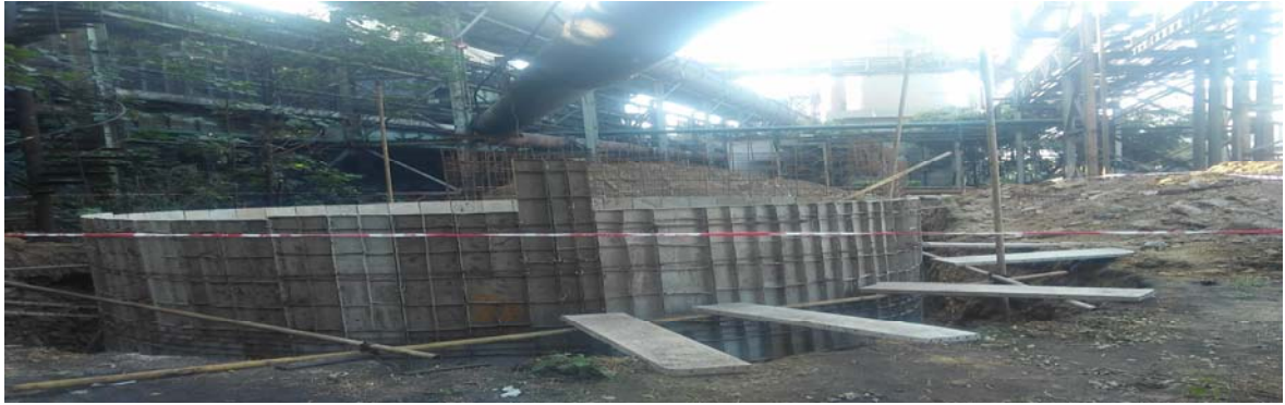
新增洗涤塔基座搭建
