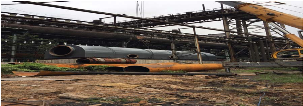
新增焚烧炉安装
